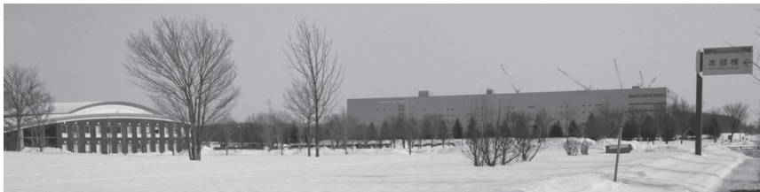
ラピダス建設中のクレーンが工場の向こうに見える千歳市美々より (左端が大学)
